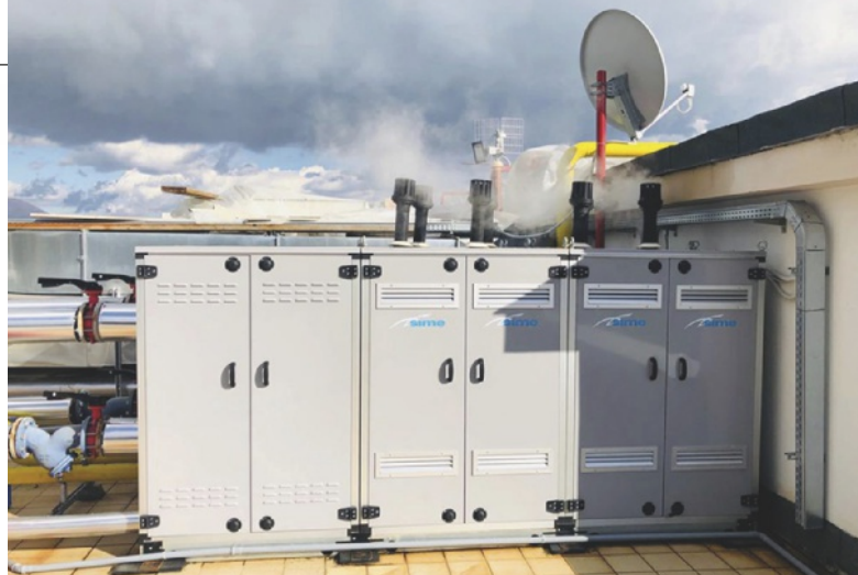
Prodotti da SIME, i generatori termici Murrelle Equipe BOX ErP sono un sistema modulare di caldaie premiscelate a condensazione, espandibili tramite accoppiamento (SIME).
